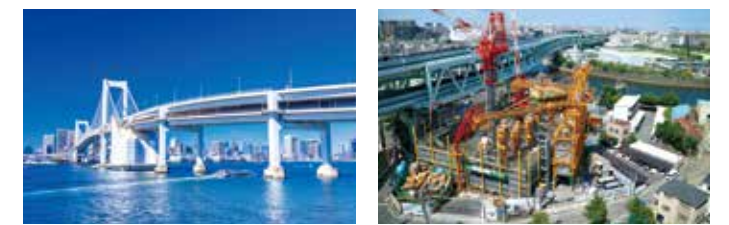
レインボーブリッジ 王子ポンプ所
