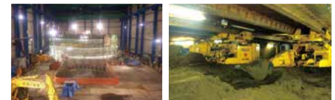
工事現場の視察の様子 掘削機「DREAM II」
